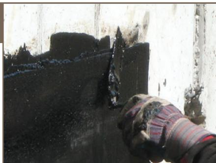
Sceller l'extrémité supérieure et tous les chevauchements à l'aide d'une truelle et d'un chalumeau.
