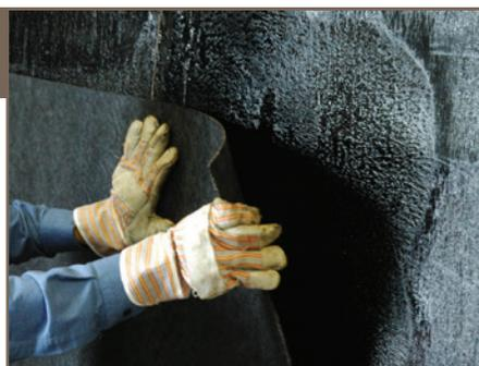
Coller le panneau de protection, d'isolation ou de drainage directement sur la membrane.
