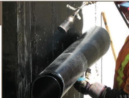
Installer la membrane COLPHENE TORCH'N STICK par thermofusion sur le mur de fondation, suite au séchage complet de l'apprêt.
