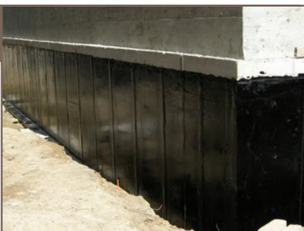
Utiliser un chalumeau pour fondre le film et chauffer légèrement la surface de la membrane pour dévoiler la surface collante.
